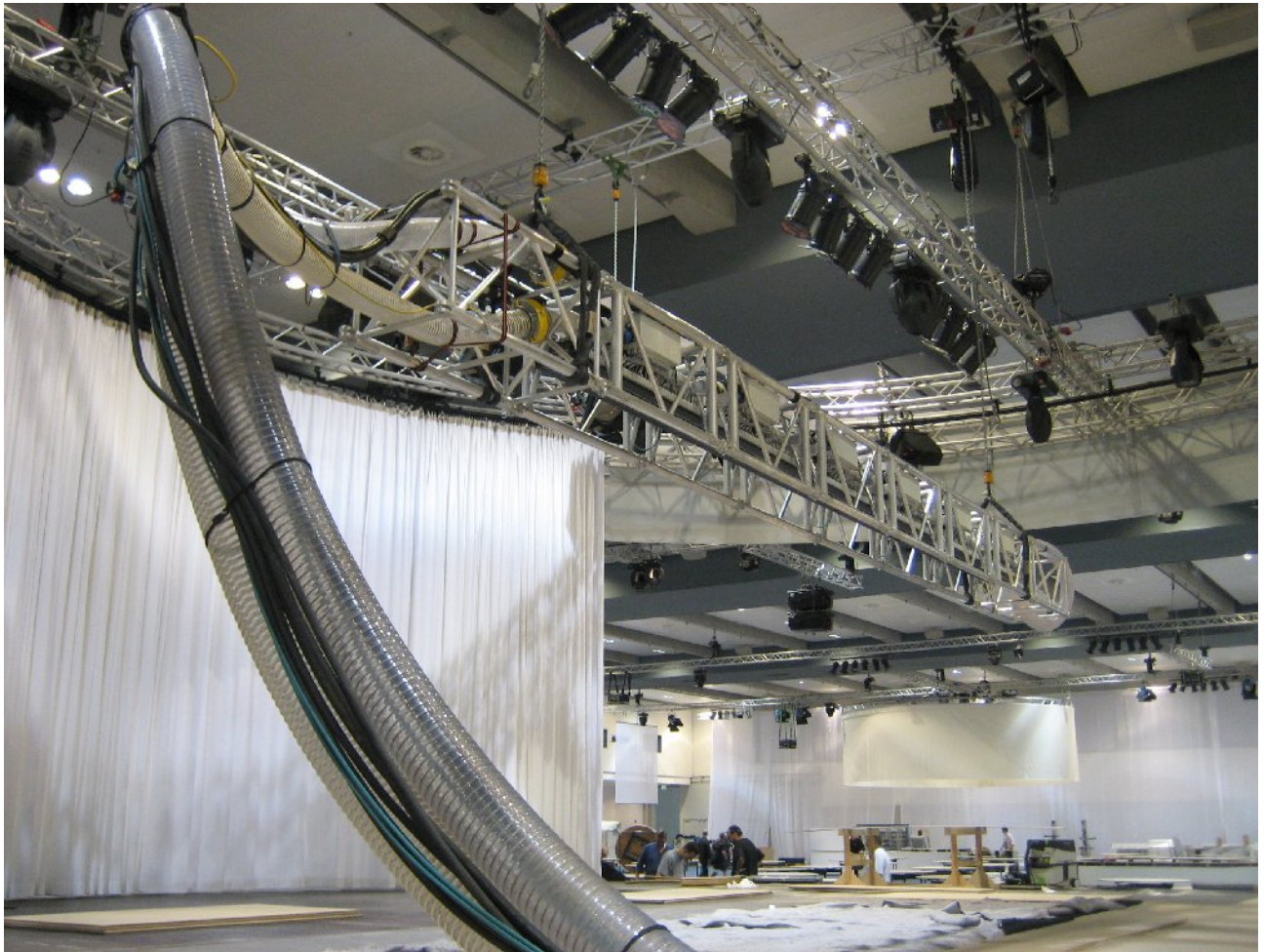
Illustration 15: Die Bühne im Rohbau. Vorn die Verschlauchung des Wasserfalls vor dem Aufziehen ins Dach, links der provisorisch vorn zusammengesobene Hauptvorhang.
