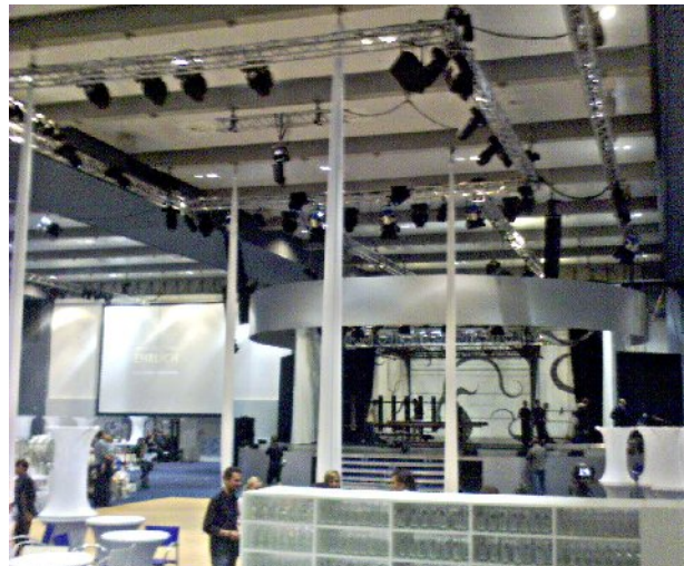
Illustration 12: Während der Stapler-Probe. Links unterhalb der Leinwand die Rangierfläche. Auf der Bühne sind die Gestellwagen zu sehen. Das Hallentragwerk aus Bindern (bläulich) und Querträgern (grau) ist hier gut zu erkennen.
